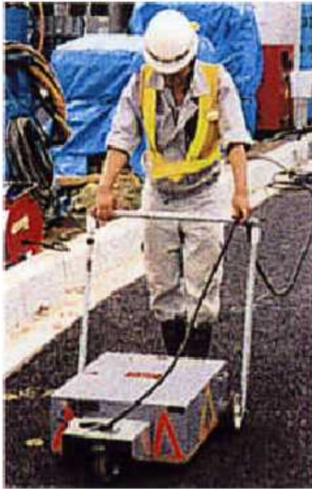
レーダー探査実施状況
